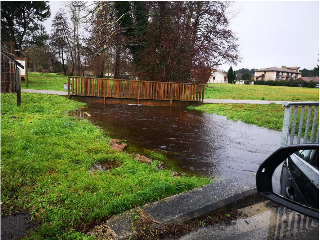
Inondation pont de l'Homy d'Ahas la Padaou – Janvier 2021
